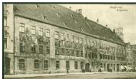
8900 Augsburg Fuggerhaus gelaufen 16.10.1915
