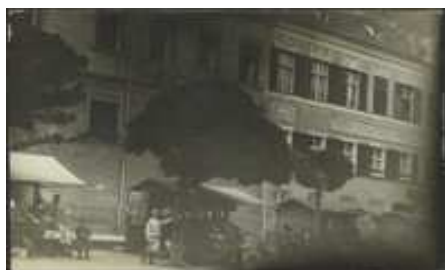
8900 Augsburg Farben-/Firnesfabrik gelaufen 1911
