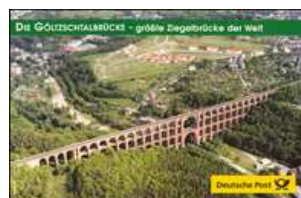
Göltzschtalbrücke SSt Reichenbach 14.10.1999 KET 141099 ausv.
